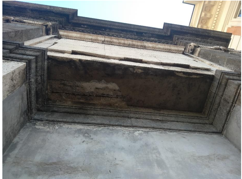
Foto 2 - Piattabanda a destra del fronte: fenomeni di espulsione del copriferro e di ossidazione delle armature
