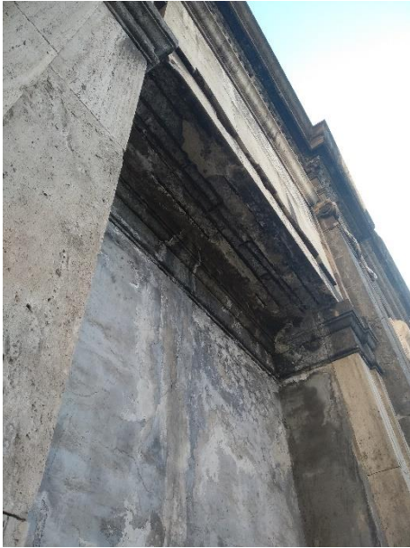
Foto 3 – Piattabanda a sinistra del fronte: fenomeni di espulsione del copriferro e di ossidazione delle armature metalliche
